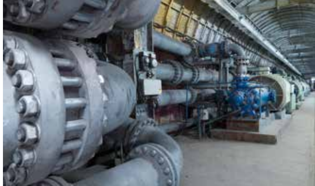
Pumpenkammer der zentralen Wasserhaltung der RAG Aktiengesellschaft auf dem Welterbe Zollverein.
